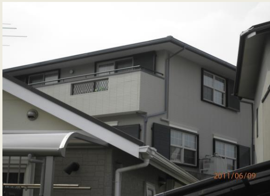
▲施工後 施工完了時期：6月初旬
