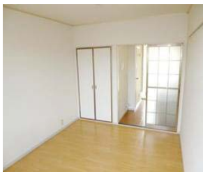
1階：天井・内壁にガイナ塗装
